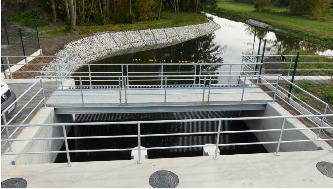
Fot 1. Pompownia przeciwpowodziowa w Czarnowie. Źródło: Archiwum Urzędu Gminy w Złejwsi Wielkiej.
