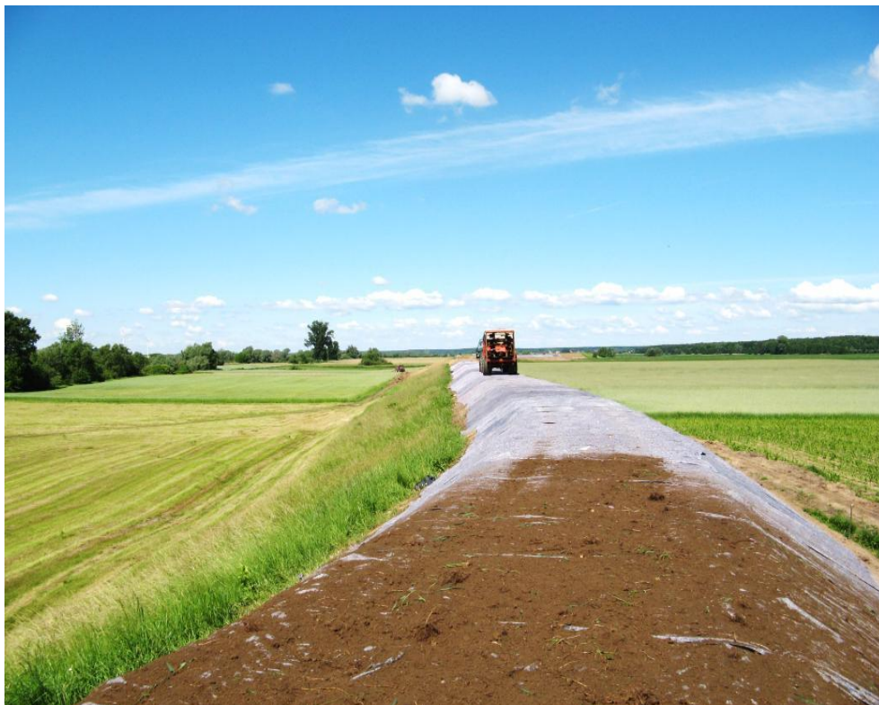
Fot 2. Zmodernizowany wał przeciwpowodziowy w gminie Zławieś Wielka, źródło KPZMiUW
